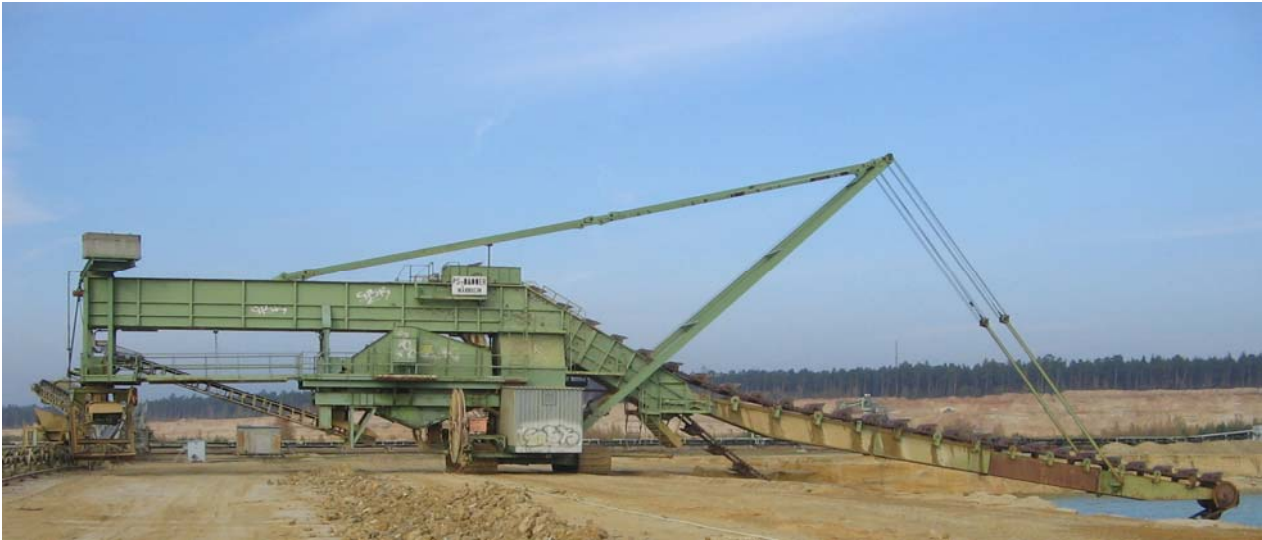
Рис. 3.23. Загальний вигляд ланцюгового екскаватора під час роботи на піщано-гравійному родовищі
